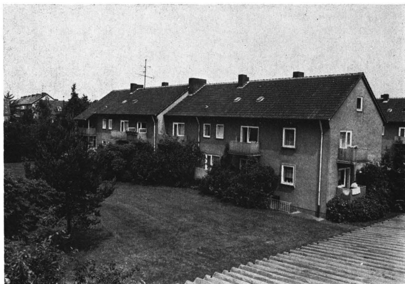
Eines der drei Wohnhäuser an der Buckstraße in Münster
