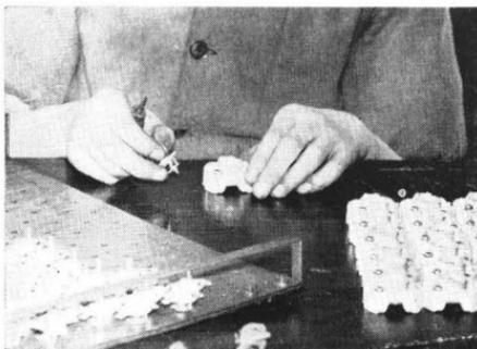
Zusammensetzen der Schalterbrücke mit Stein
